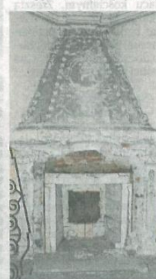
Jeden z zachowanych kominów na parterze.
